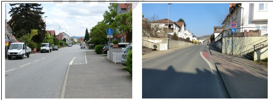
Abbildung 17: Beispiele für gut gelöste Ausleitungen auf die Fahrbahn. Links: Musterlösung / Rechts: Minimallösung [Fotos: R+T]
