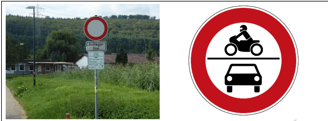
Abbildung 10: Fehlerhafte StVO-Beschilderung am Wullesee (links) und korrektes Verkehrszeichen 260 StVO (rechts) (Fotos: R+T)
